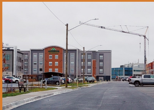
Travaux d'amélioration stationnement (Centre-ville)
